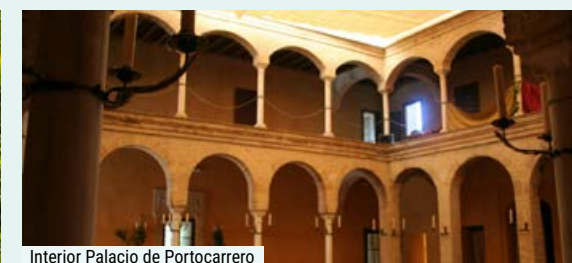
Interior Palacio de Portocarrero
